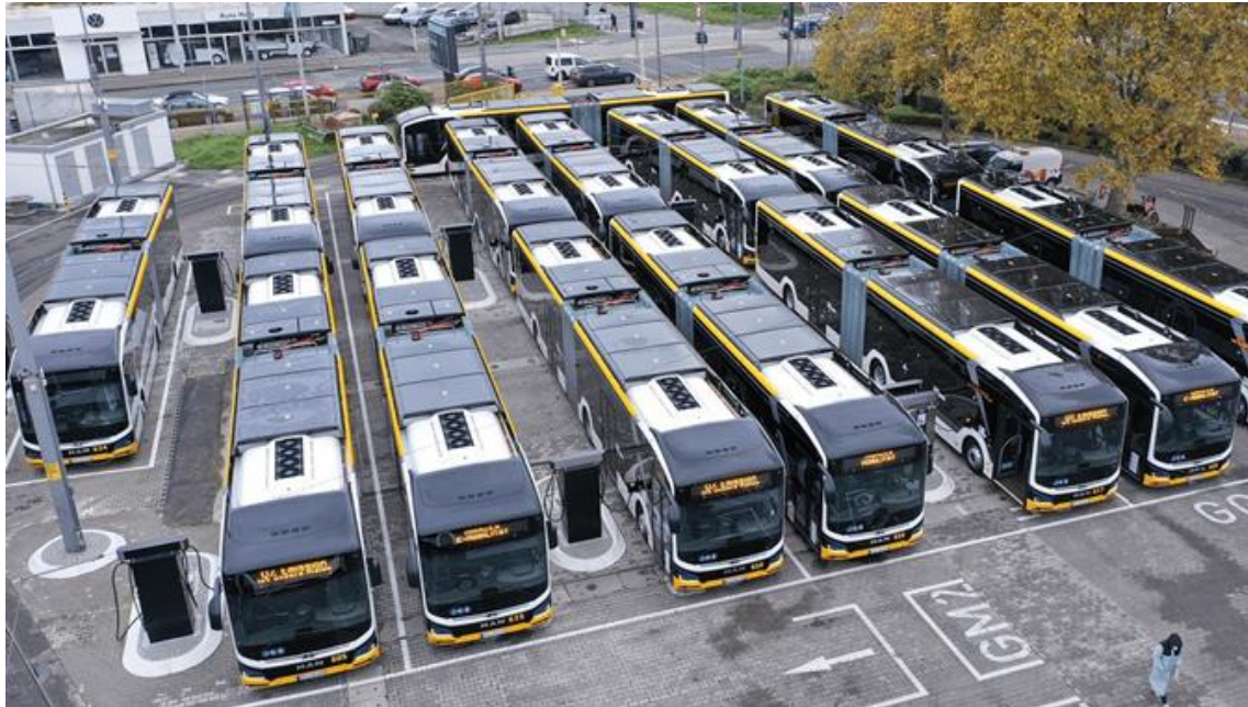
Abbildung 63: Steckerladung im Depot der Mainzer Verkehrsgesellschaft mbH [24]
